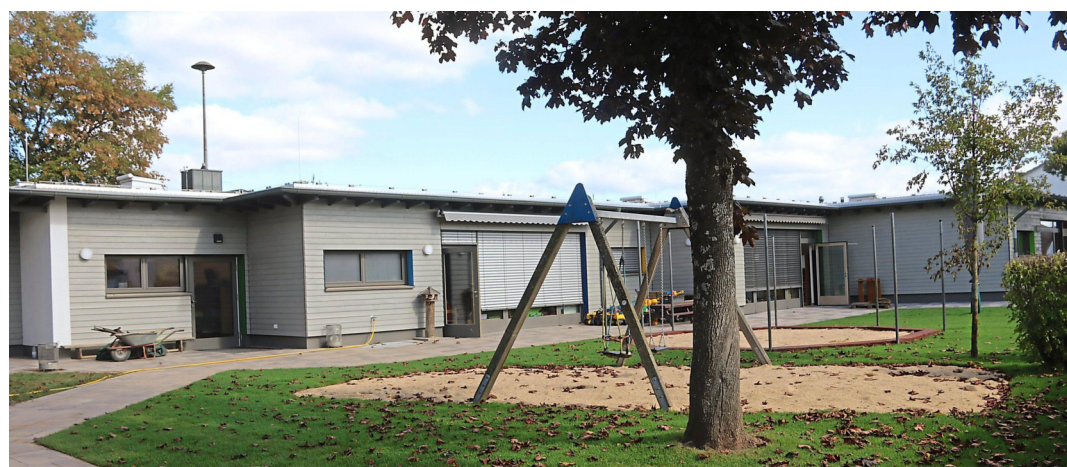
Kindertagesstätte Röddenau: Nach zwei Jahren Umbau- und Sanierungszeit kann die Kita Röddenau nun wieder vollständig genutzt werden. Kosten: rund 4 Millionen Euro. Am Samstag gibt's für die Bevölkerung einen „Tag der offenen Tür“. FOTO: MJX
