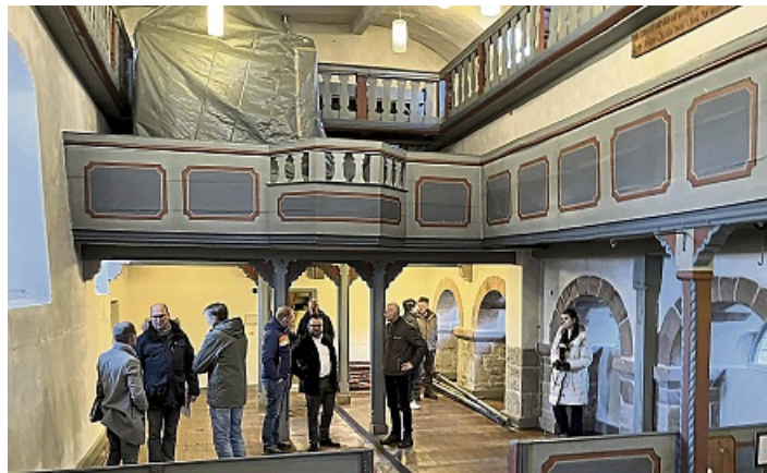
Ausgeräumtes Kirchenschiff: Auch die historische Goll-Orgel von 1897 (oben links) ist schon von den Orgelbauern staubdicht verpackt worden.
