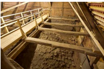
Dachstuhl über Chorgewölbe
