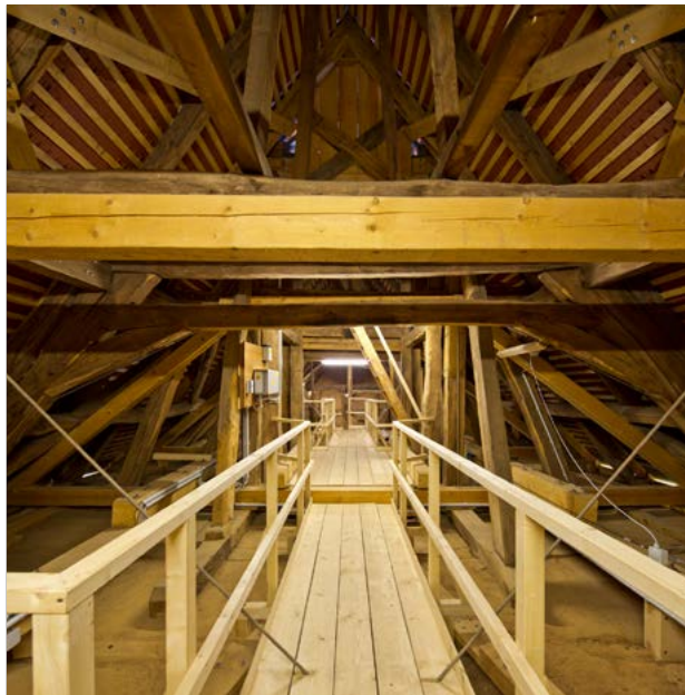
Dachstuhl mit neuem Wartungsgang
